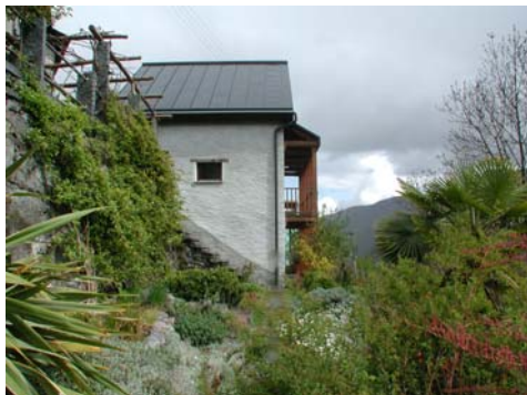
Blick vom Ziergarten Richtung Osten
